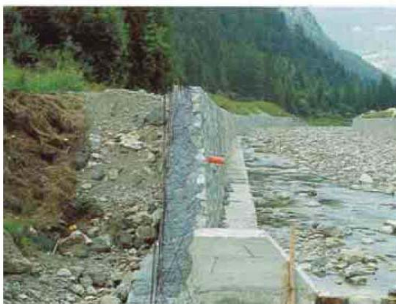
Figura 31. Esempio di opera di sostegno spondale realizzata in cemento armato con cassaforma a perdere rivestita in pietrame. Il tubo in PVC materializza la feritoia per il drenaggio.
